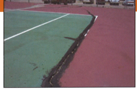
液状アスファルト充填
