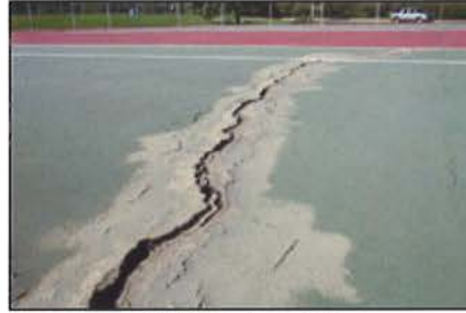
樹脂モルタル充填
