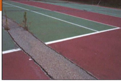
アスファルトの部分打ち替え
