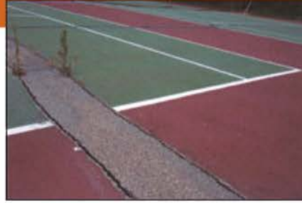
アスファルトの部分打ち替え
