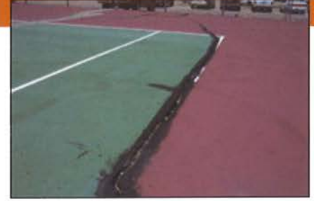
液状アスファルト充填
